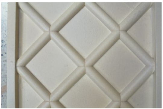
▲仕上げ塗材(ネフ)吹き付け状態
