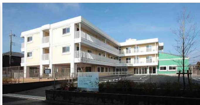
完成した施設
